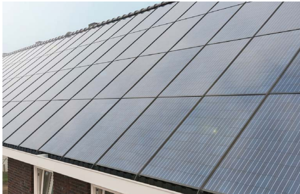
zonnepanelen geïntegreerd in het dakvlak
