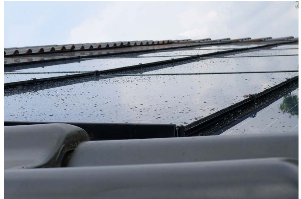
zonnepanelen verzonken in het dakvlak
