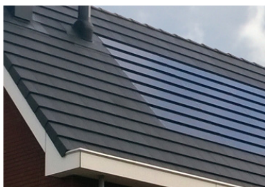
panelen verwerkt in het dak
